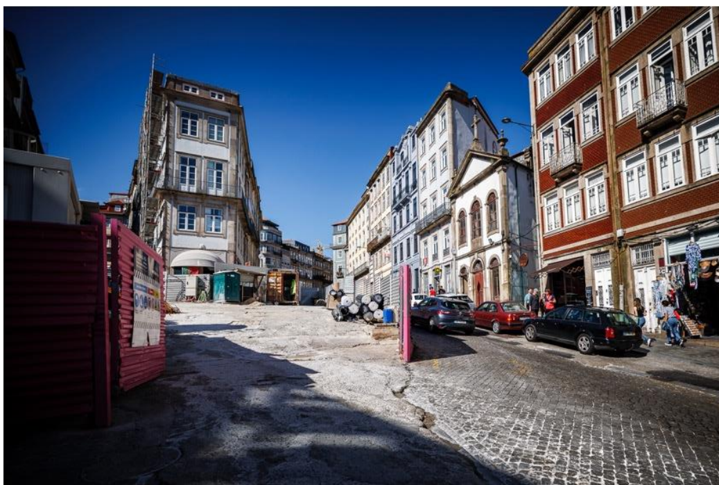
Figura 2 - Fotografia do estaleiro junto ao Mercado Ferreira Borges em 24/05/2024
