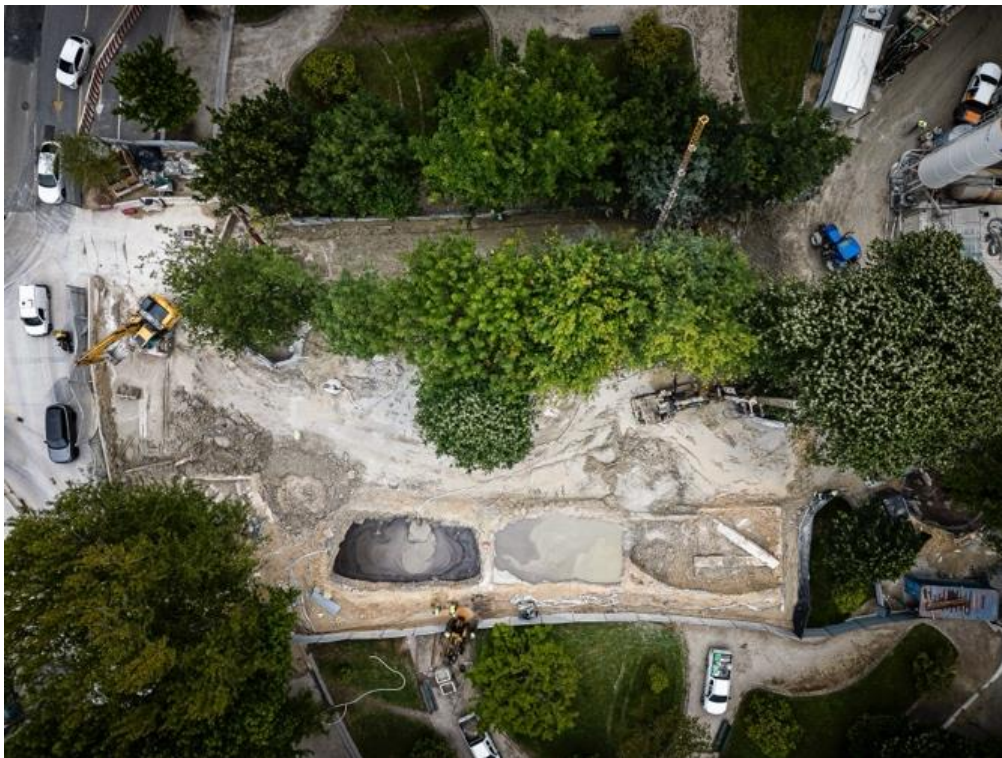
Figura 13 - Vista aérea da Praça Mouzinho de Albuquerque 15-05-2024
