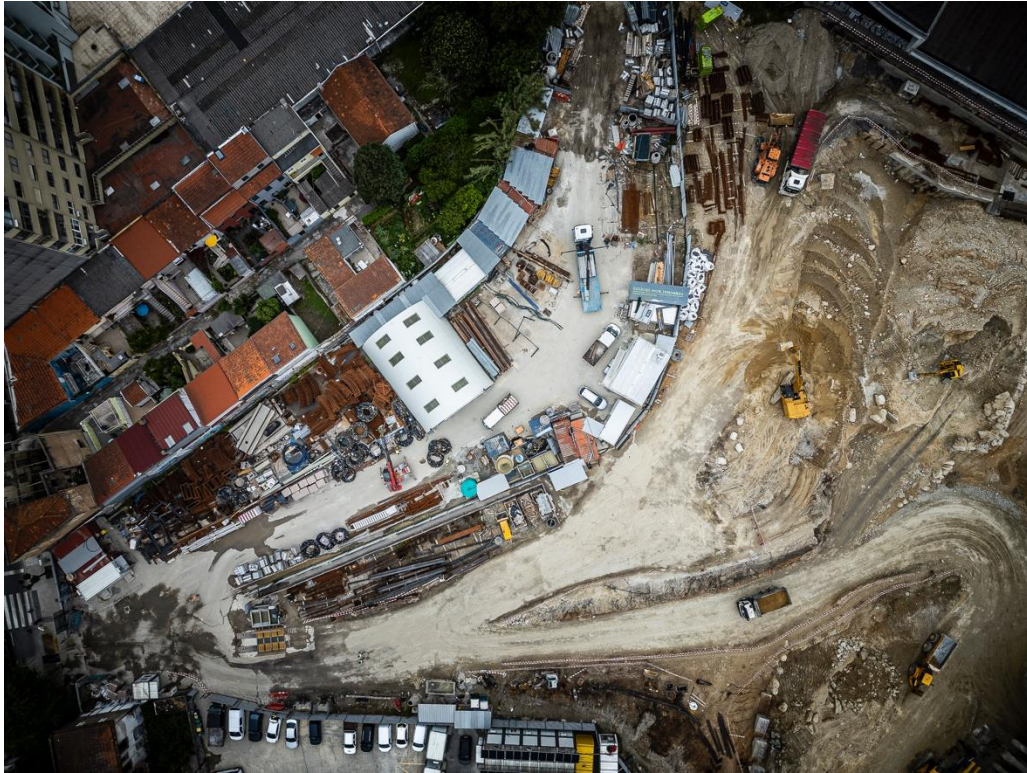
Figura 23 - Vista aérea do estaleiro na Boavista em 15/05/2024
