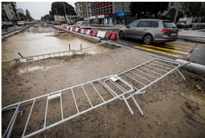
Foto 1 - Passadeira provisória na Avenida da Boavista (28 março 2024).
