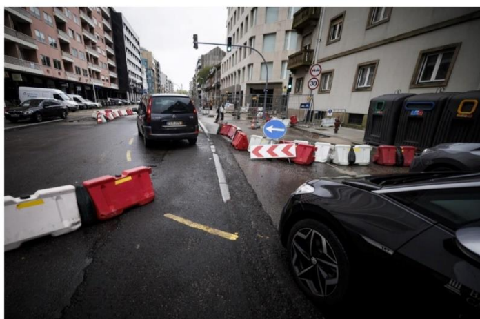
Foto 22 - Barreiras delimitadoras do espaço que se deslocaram, estrangulando uma mudança de direção que passou de duas a uma faixa de rodagem (sentido ascendente da Avenida da Boavista) (28 março 2024).
