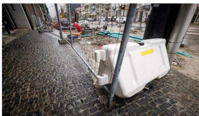
Foto 9 - Acesso provisório a um edifício na Avenida da Boavista (28 março 2024).
