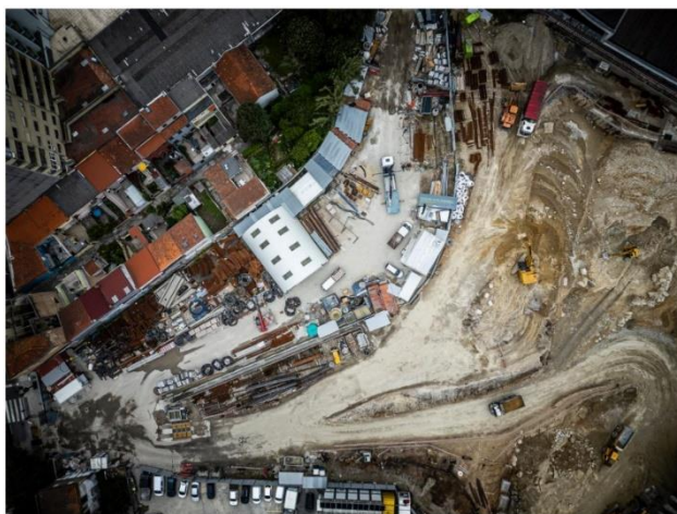
Figura 23 - Vista aérea do estaleiro na Boavista em 15/05/2024
