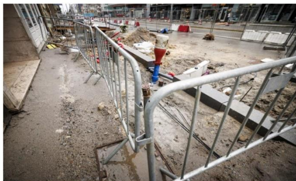
Foto 10 - Acesso provisório a um estabelecimento comercial na Avenida da Boavista (28 março 2024).
