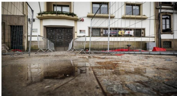
Foto 8 - Acesso provisório a um edifício na Avenida da Boavista (28 março 2024).
