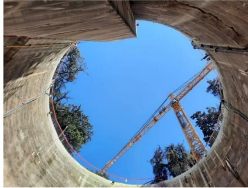
Figura 14 - Poço no Jardim do Carregal (internet 30/05/2024)
